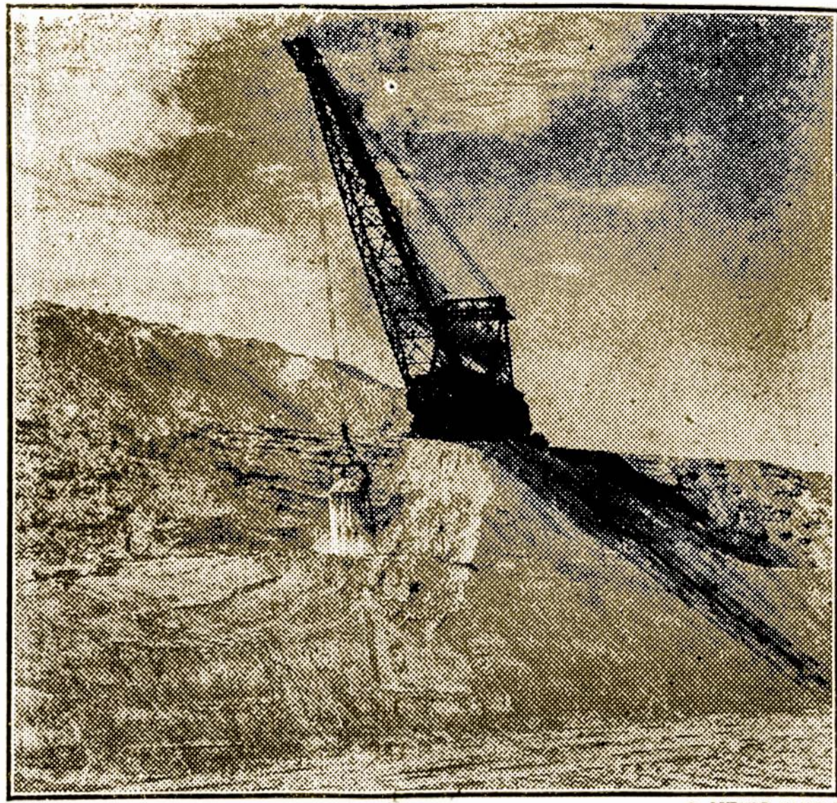
KASA KANALĄ PER DYKUMOS KOPAS Milžiniška garinė bertuvė lygina amerikono kanalą arti Meksikos sienos. Šitas didelis drėkinimo griovis perleis vandenį iš Boulder Dam į Imperial Slėnį, tai bus dalis plataus Boulder Slėnio atitaisymo projekto įvykdyta.
