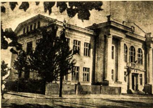
Zarasų gimnazijos rūmai
