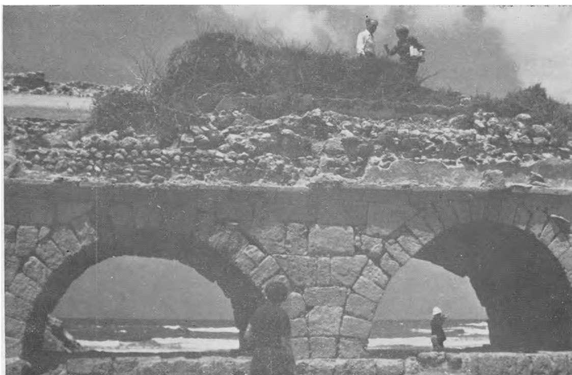
Romėnų laikų vandentiekis prie Cezarėjos.
