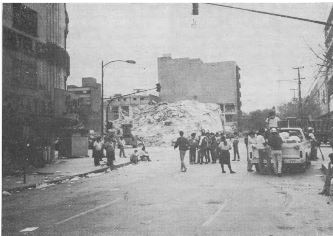
Meksikos sostinės gatvės po žemės drebėjimo.
