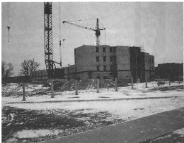
Šv. Juozapo darbininko bažnyčios statyba Klaipėdoje.
