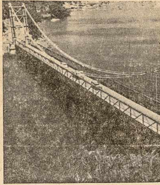
Ponte Pensil, kabantis tiltas turintis 100 mt. ilgio kuriuo pasiekama iš São Vicente - Praia Grande.
