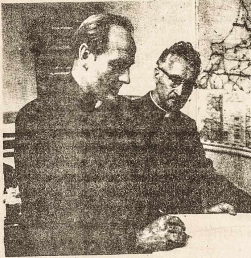
Tėv. Gediminas Kjauskas, SJ, Clevelando lietuvių parapijos klebonas su Tėv. J. Zaremba
