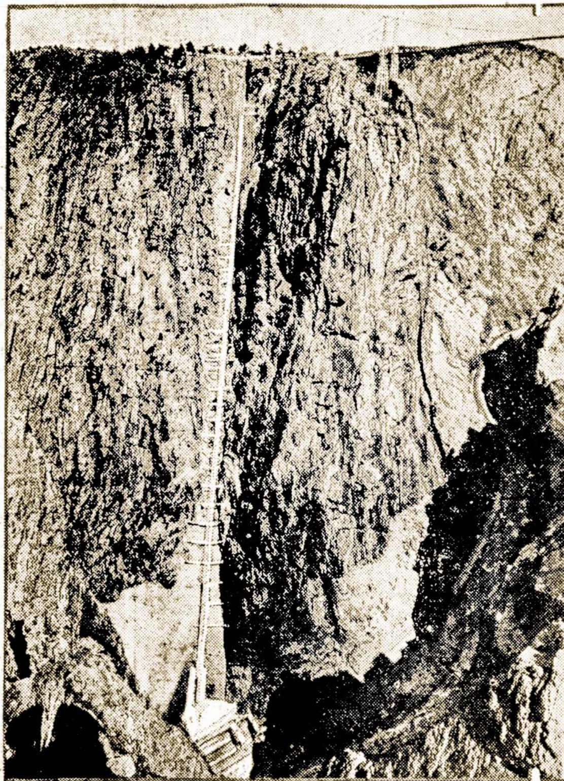
Šis gelžkelis yra stačiausias pasaulyje. Jis eina 45-kū laipsnių statumu ir užėina į kalną 1725 pėdas aukštumo. Jis yra valdomas naujausiais stbdytūvais ir yra laikomas žymiausiu inžinerijos padaru.
