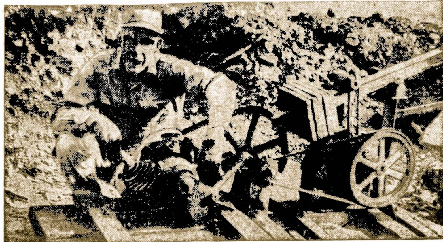
Al Smith, 51 m., iškasė šulinį Newcastle, Wyo., ir iš 24 pėdų gilumos per dieną ištraukia dvi statines alvyvos. Jis savo siurbliui panaudojo skalbiamos mašinos motorą.
