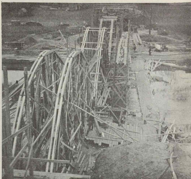
Siaurojo geležinkelio Joniškėlio-Vaškų-Žeimelio ruože, arkiniam gelžbetoniniam tiltui per Mūšos upę, formų sustatymo darbai (1940 m.).
