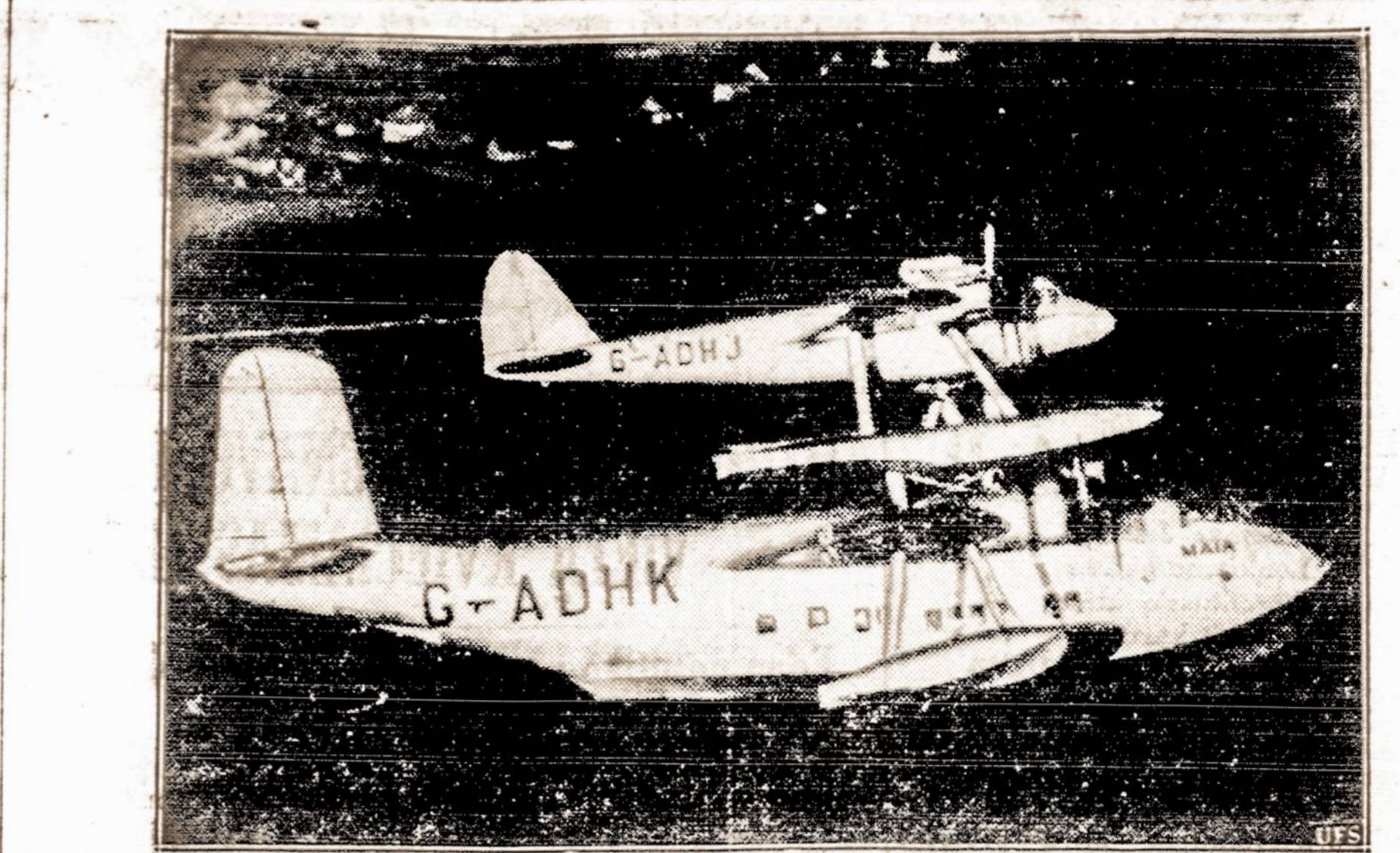
Skraidanti motina su savo vaiku. — Pasireiškia dar didesnė pažanga aviacijoje. Anglijoje daromi įdomūs bandymai. Pakiles į oro didelis lėktuvas nešasi ant savo nugaros kitą mažesnę lėktuvą, kuris veža daug gazolino. Tuo būdu mažesnis lėktuvas lengviau gauna pradžios greitį, reikalingą pakilimui. Abiejų lėktuvų lakūnai susikalba telefonu.
