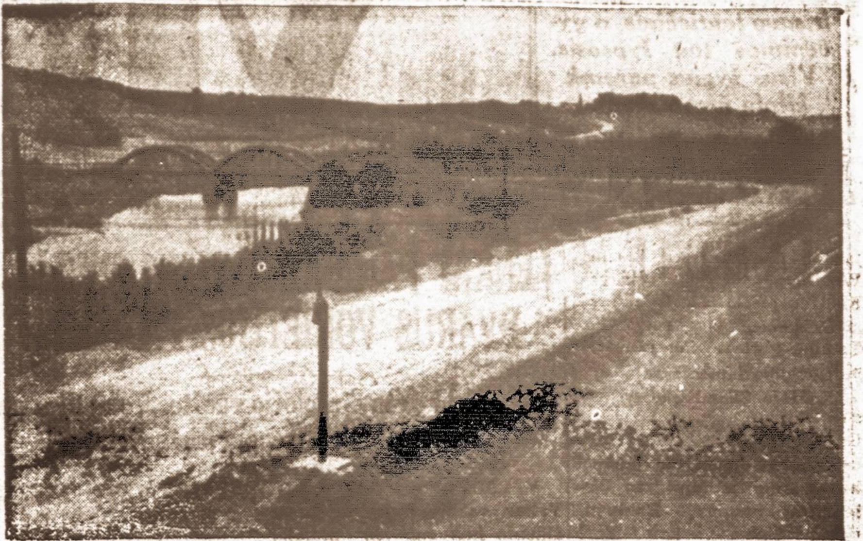
Zemaičių plentas ties Airiogal a. — Vaizdelyje matome Dubysos upę ir gelžbetoninį tiltą.
