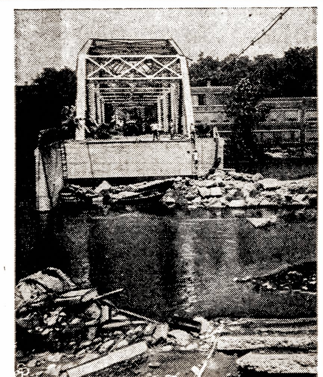
Mažai kas liko iš geležinkelio tilto, ėjusio skersai Farmington upe, Unionville, Conn. Pakilęs upės vanduo nusinešė tiltus, fabrikus ir net 66 žmones. Connecticut valstybės nuostoliai, padaryti uragano ir liūčių metu, peršokę bilijoną dolerių.
