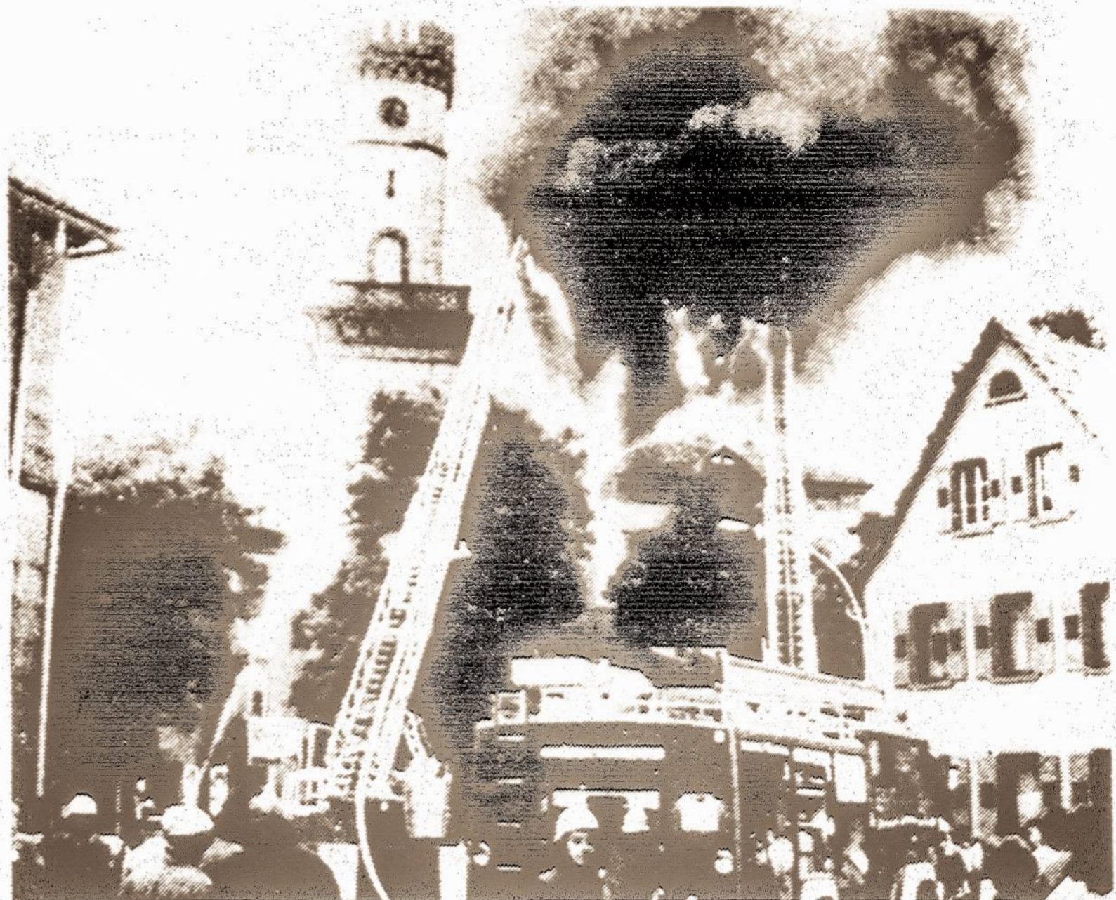
Tiršti dūmai veržiasi iš senosios pilies, Vasario 16 gimnazijos centro. Ugniagesiai darbavosi net septynias valandas, ligi ugnį numalšino ir viską supylė vandeniu, daugiau padarydami žalos, nei naudos.
