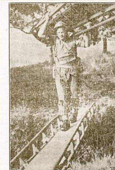
Pats sau pasitiesia tiltą ir pats eidamas nuima jį. Anglijos karėvis eina per upelį. Jis eidamas viena tilto sekcija, nešasi su savim jau perėitį sekciją, kurią paskui vėl priekin pasideda.
