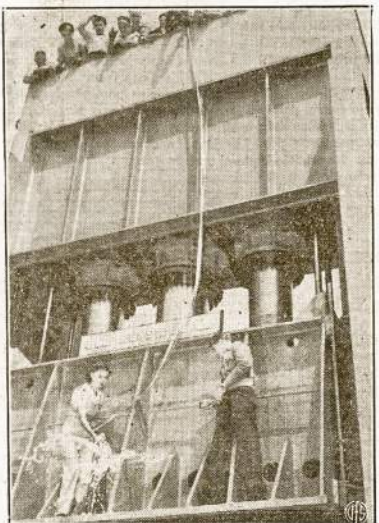
Didžiausia pasaulyje automatiška mašina. "Old Ironside," kuri neseniai įtaisyta vienoje orlaivų irbtuvėje Los Angeles. Mašina-pressas turi 1,100 tonų spaudimo jėgą ir vienu kirčiu pagamina tam tikrą didelę dalį Liberty orlaivo.
