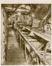
Šis elektrikinės konvėras pri stotė cemento, smėli ir žvyra į betono mailytuvą.
