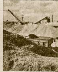
Užpakalyje matytis elektrikinės betono mailytuvus, specialiai gumintis šiam darbu.
