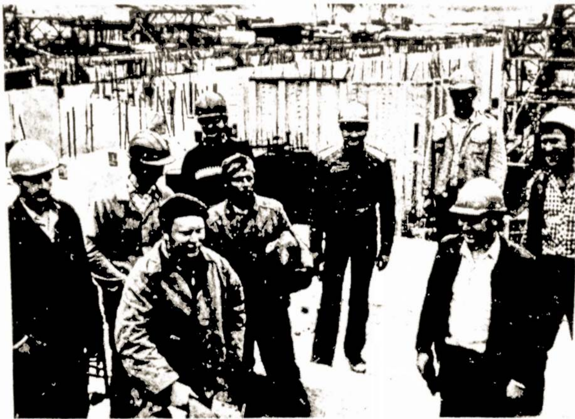
Kaišiadorių HAE statybos pirmaujanti Romo Ignoto kompleksinė brigada su gera nuotaika pradeda pamainą.
